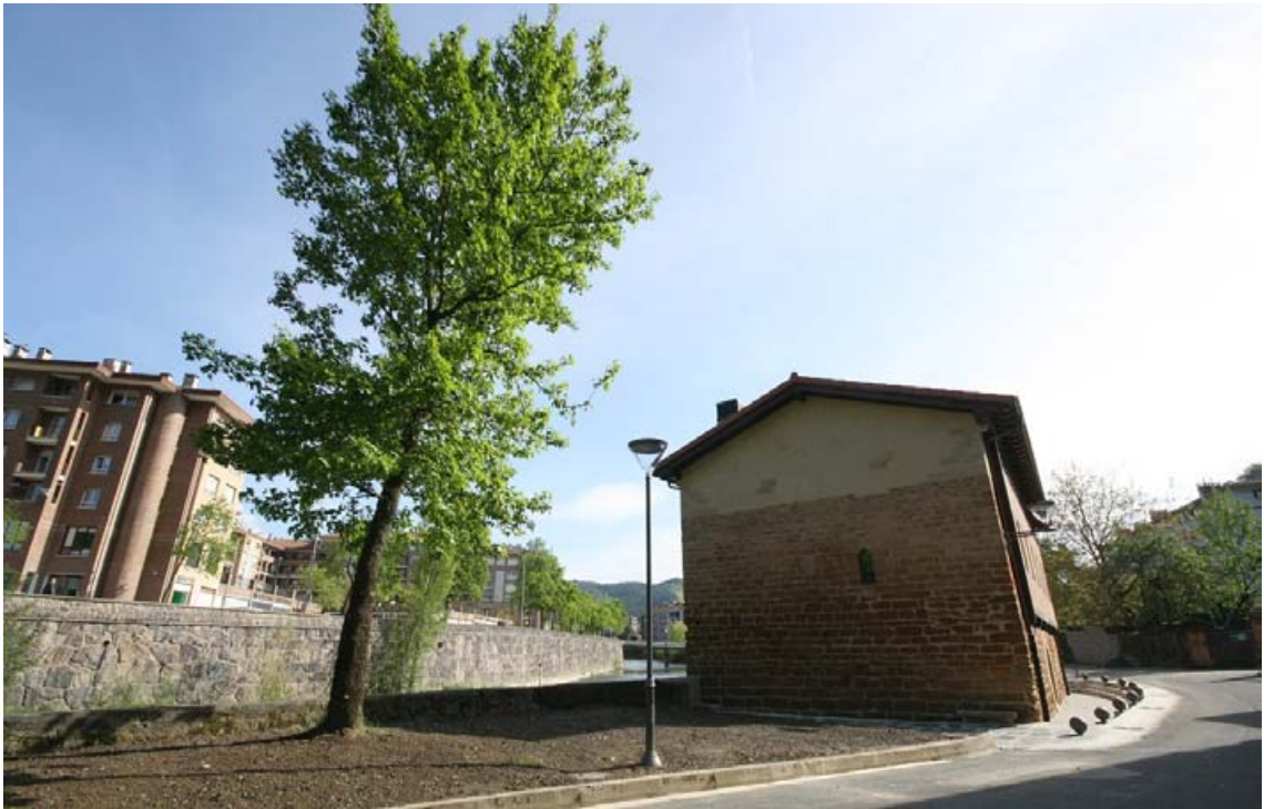
Foto 5: Fachada nororiental del Hospital. La ventana abierta en el muro señala la situación de la estancia ocupada por Maestro Yñigo
